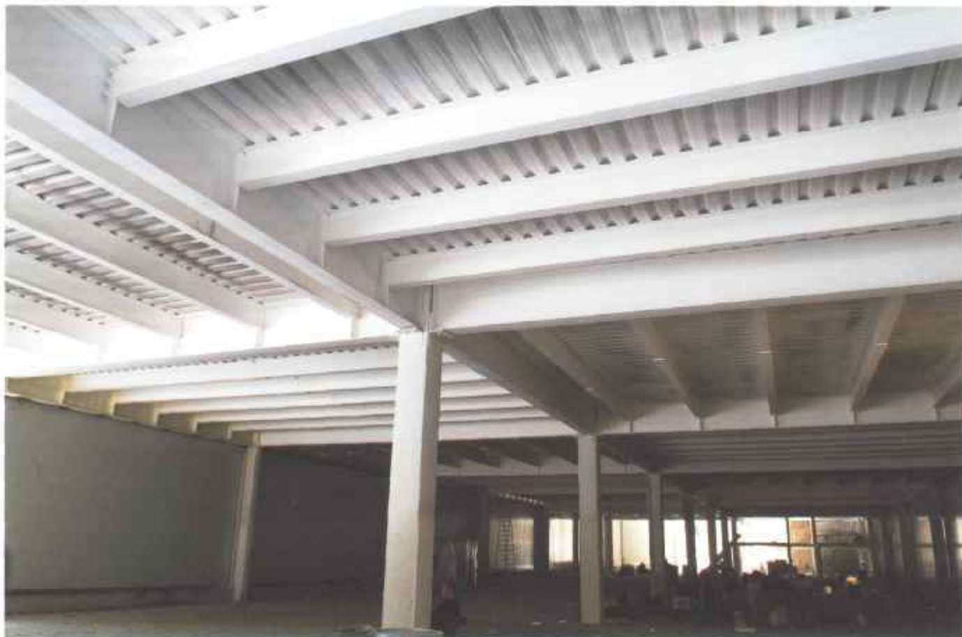
Обработанные защитным составом конструкции
